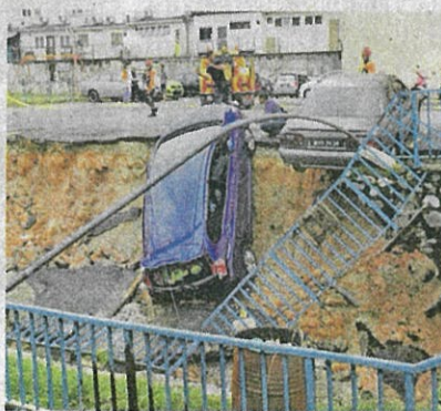
Kedudukan kereta yang jatuh ke longkang di kawasan terjejas akibat mendapan dan tanah runtuh.
