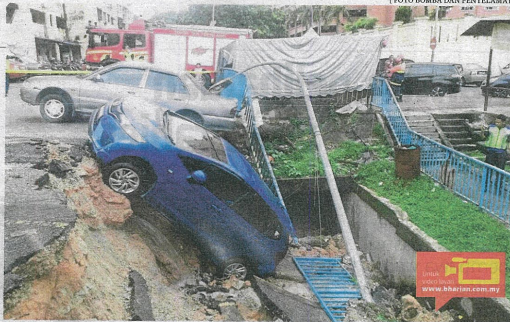
Dua buah kenderaan yang terperosok dalam kejadian hakisan tanah masih berada di tempat kejadian di Flet Midah Ria, Cheras, semalam.
