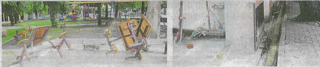
Kemudahan kerusi dan meja yang sudah rosak dibiarkan tanpa dibaik pulih. Keadaan longkang yang tidak diselenggara dengan baik.
