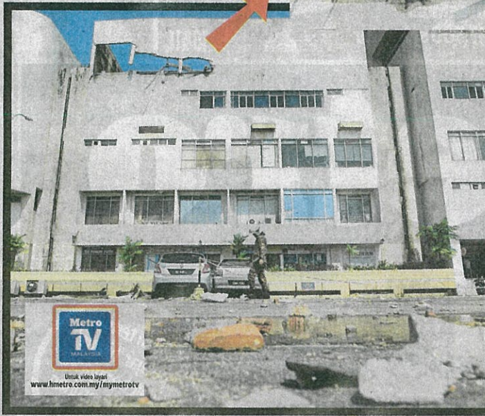
KEADAAN dinding bangunan yang runtuh selepas tangki air di tingkat 4 di Kompleks Teruntum pecah, semalam.
