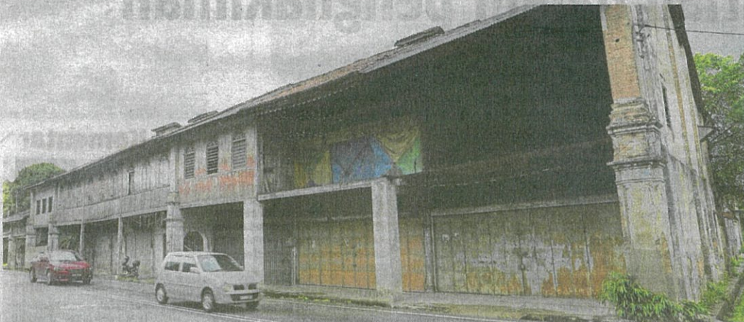
Bangunan rumah kedai lama di Kampung Kepayang Sungai Raia, Gopeng.
