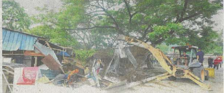
KERJA-KERJA merobuhkan premis setinggan di persimpangan selekoh Kampung Pasir, Ukay Perdana, Hulu Klang, Selangor, berjalan lancar tanpa sebarang insiden kelmarin. -UTUSAN/ROY AZIS ABD. AZIZ
