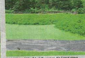
KOLAM terakhir di Loji Rawatan Air Larut yang menggunakan proses semula jadi iaitu tumbuhan aiga sebelum dilepaskan ke sungai.
