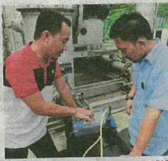
JURUTERA Worldwide Landfills, Abdul Halim Tara (kiri) dan Pengarah Operasi Tapak Worldwide Landfills, Nor Haszma Mohd Hashim membaca gas daripada saluran paip gas yang dijana daripada telaga gas.
