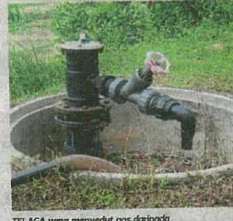
TELAGA yang menyedut gas daripada sampah dan menghasilkan bekalan elektrik.
