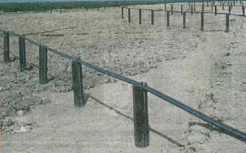
PAIP gas yang menyedut gas sampah di Tapak Pelupusan Sanitari Jeram, Kuala Selangor.
