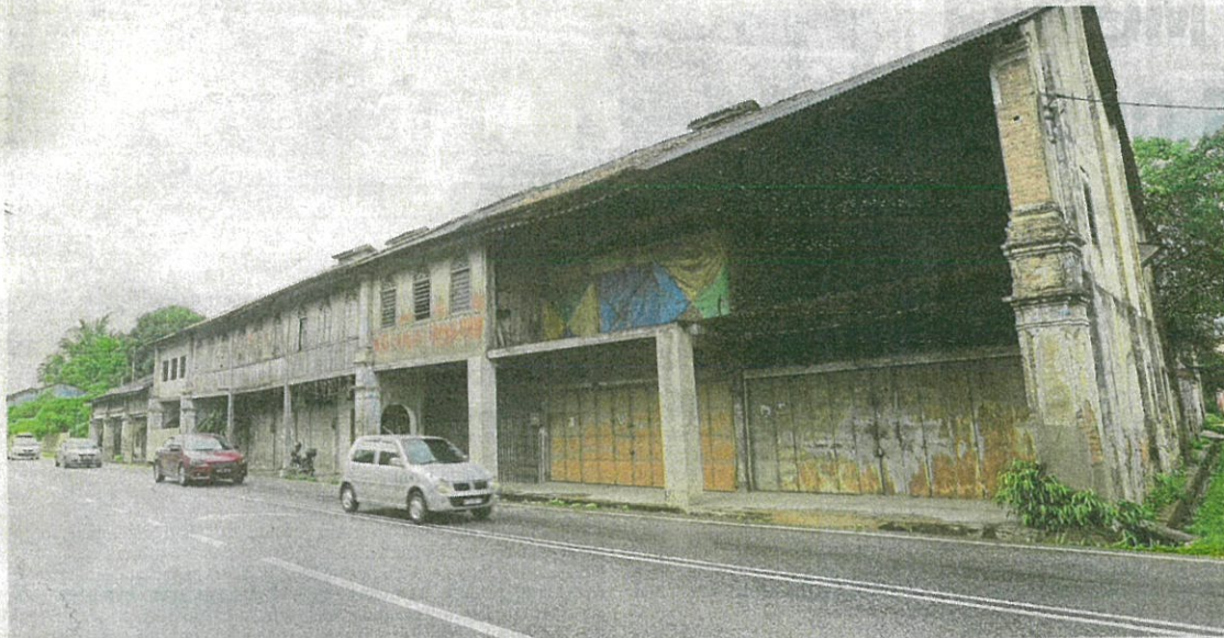
Bangunan rumah kedai lama yang dibina pada 1885 di Pekan Kampung Kepayang Sungai Raia perlu perhatian pihak berkuasa tempatan.
