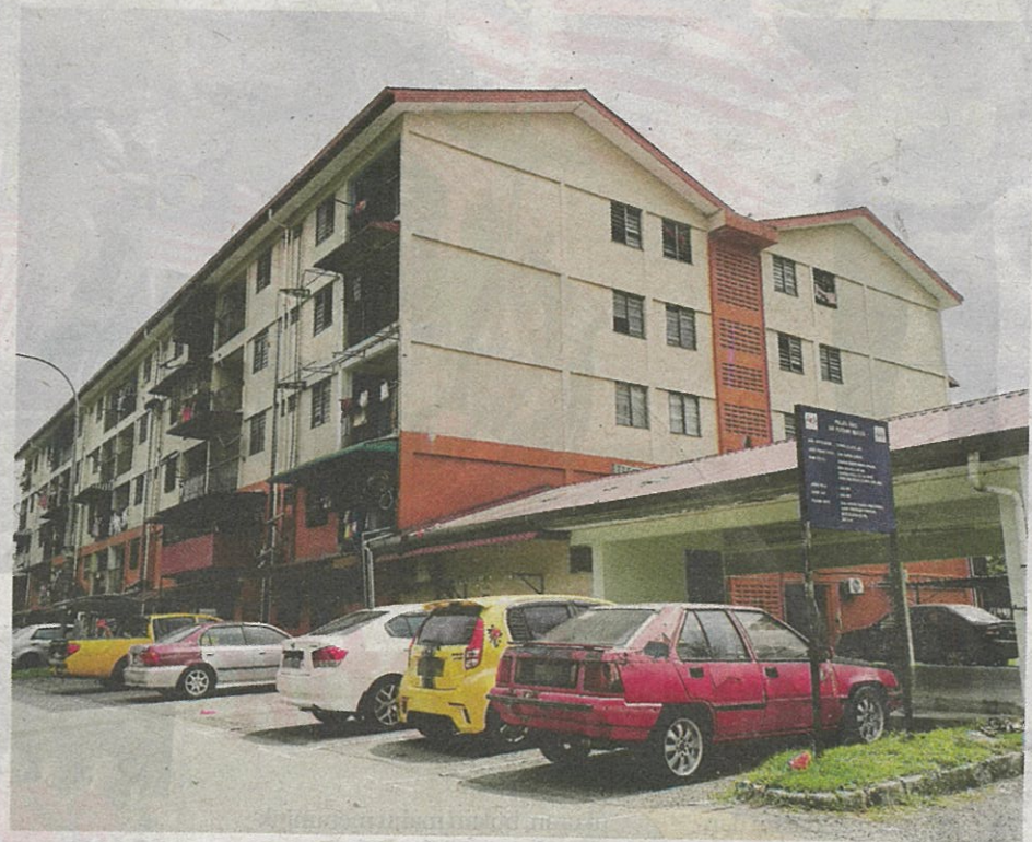
Antara pangsapuri di kawasan Bandar Baru Sungai Buloh yang berdepan masalah strata.
