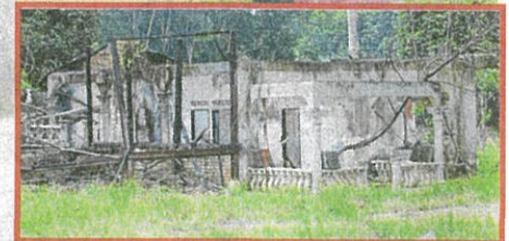
TINGGALAN bangunan asrama yang terbakar.
