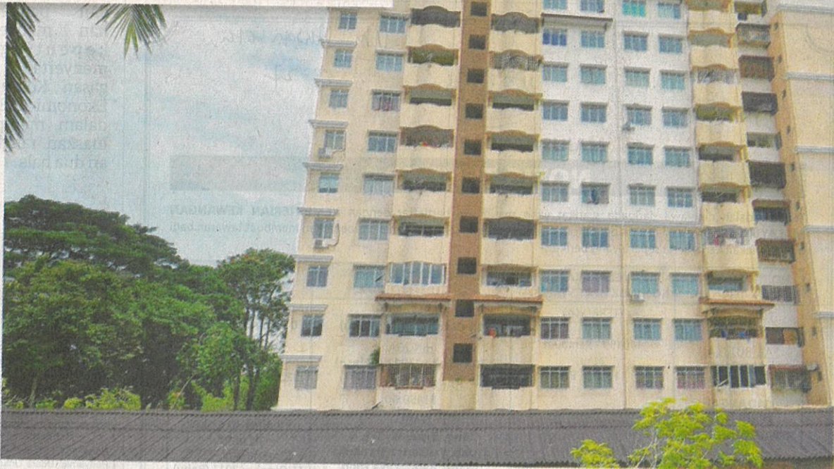
APARTMEN Vista Putra, Bandar Seri Putra Kajang, Selangor nampak indah di luar, namun penghuninya berdepan pelbagai masalah termasuk lif dan tangki air rosak. - UTUSAN/ FAUZI BAHARUDIN
