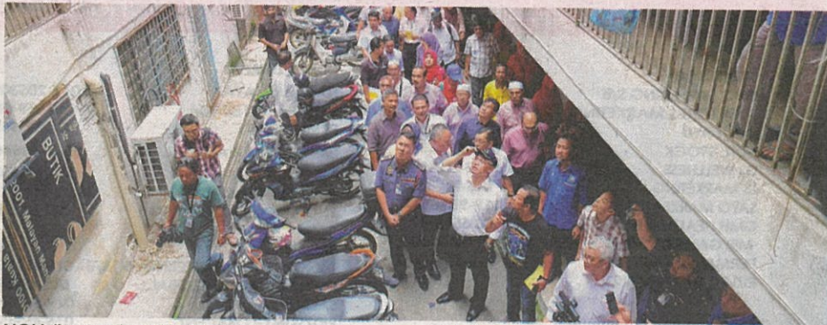
NOH (bertopi) melihat bahagian bangunan yang perlu dibaik pulih di Pangsapuri Puchong Permai di Puchong, Selangor semalam.
