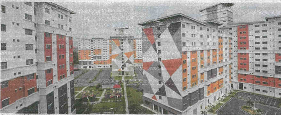
Antara Projek Perumahan Rakyat yang siap dibina di Sungai Melana, Johor Bahru.
