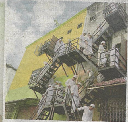
Pelajar keluar mengguna pintu yang dihubungkan dengan tangga khas untuk keluar dari bangunan sekiranya insiden kecemasan berlaku.
