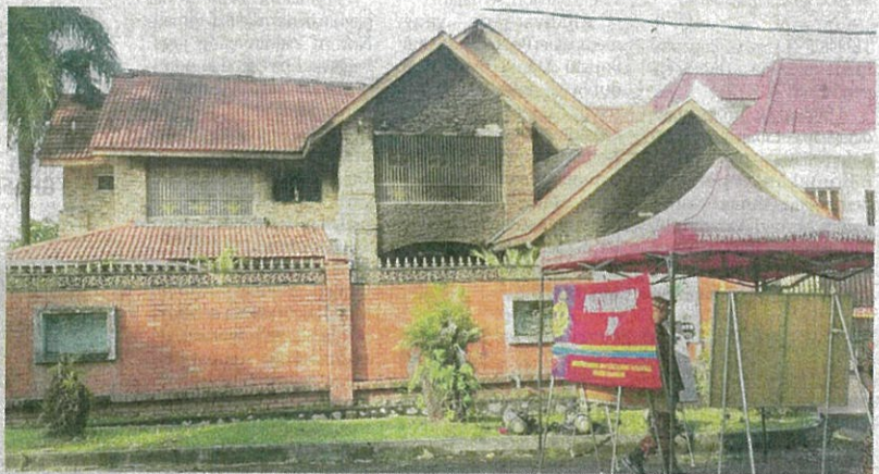
Keadaan pusat jagaan orang tua di Sungai Long selepas insiden kebakaran yang mengorbankan lima mangsa, pagi semalam.
