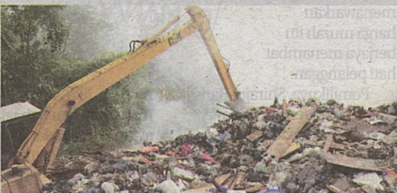
Jentera digunakan bagi mengurai sampah bagi memadamkan kebakaran di dasar timbunan sampah domestik dan sisa binaan.
