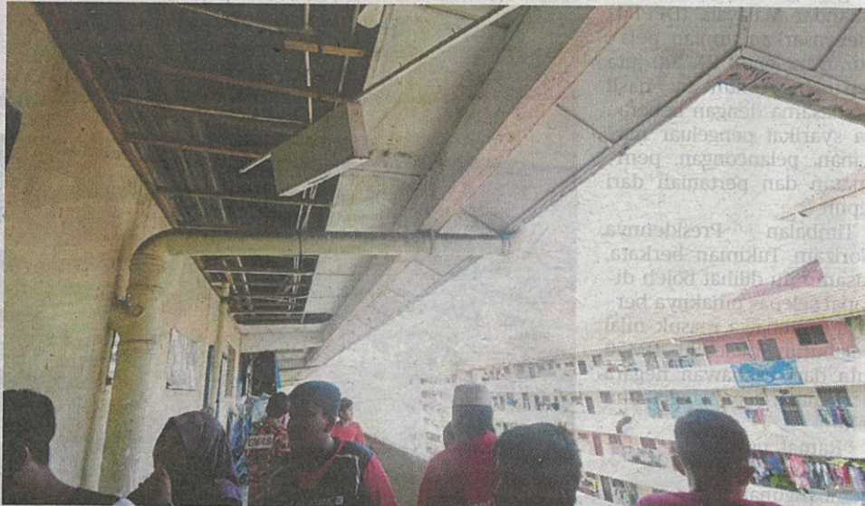
KEADAAN siling rosak selepas tangki air pecah di Blok E, Flat Seri Perantau Pelabuhan Klang.
