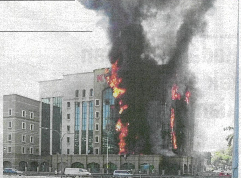
Api marak pada bahagian dinding bahagian luar bangunan KWSP, Jalan Gasing, di Petaling Jaya semalam.
