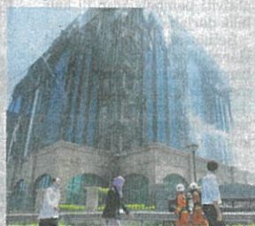
BANGUNAN KWSP terbakar selepas percikan api daripada kerja-kerja mengimpal besi di tingkat satu terkena penebat dinding polyfoam.
