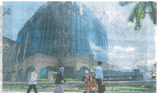
BANGUNAN KWSP ini terbakar selepas percikan api daripada kerja-kerja mengimpal besi di tingkat satu terkena penebat dinding polyfoam.
