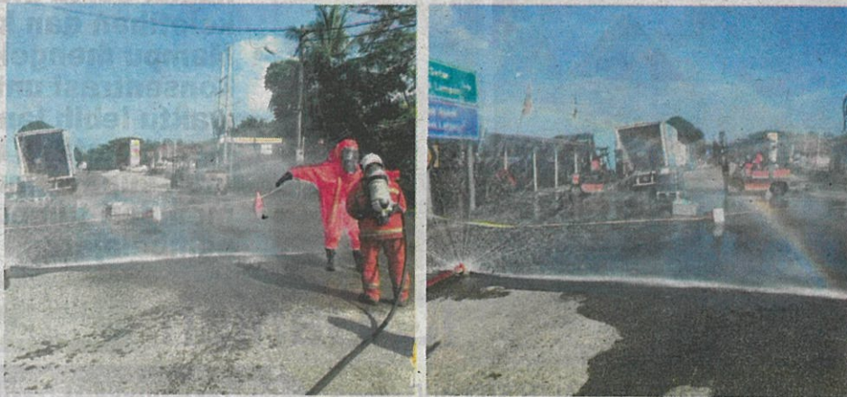
ANGGOTA bomba membersihkan bahan kimia asid nitrik yang tumpah di atas jalan di Sungai Dua, Butterworth, Seberang Perai semalam.
