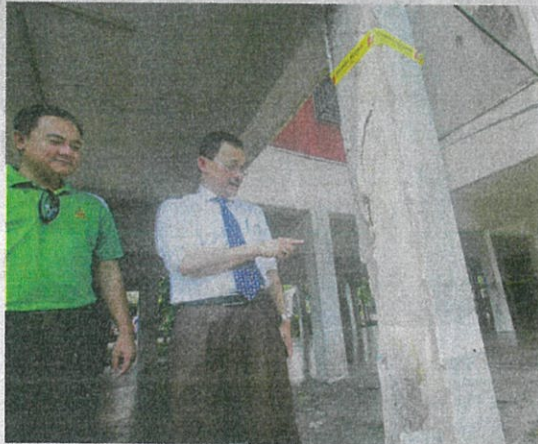
ROSLI OTHMAN (kanan) menunjukkan kesan rekahan pada tiang salah satu pangsapuri di Bandar Baru Bangi, semalam. - UTUSAN/AZLAN HADI ABU BAKAR
