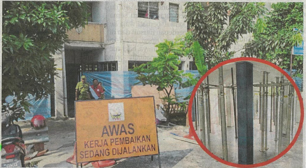
KAWASAN flat dalam proses pembaikan. Gambar kecil, batang besi yang dipasang sebagai penahan.
