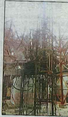
被烧毁的电讯塔是位于双溪沙翁垦殖区附近的油棕园，消防局目前仍在调查起火的原因。
