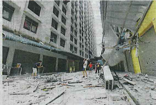
PENDUDUK rumah pangsas Desa Green, Jalan Paya Terubong, Ayer Itam memerhatikan serpihan batu-bata sebuah unit rumah pangsas di Tingkat 20 yang jatuh ekoran kejadian letupan, semalam.
