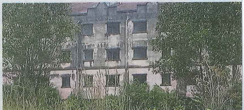
Bangunan lot kedai yang usang dan bersemak samun di Taman Widuri dan Kemboja, Bukit Sentosa, terbiar sejak 1995 mengundang masalah kepada penduduk. (Foto Md Fuzi Abd Lateh/BH)
