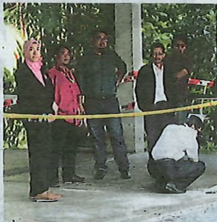
PEGAWAI memeriksa keadaan tiang rumah.
