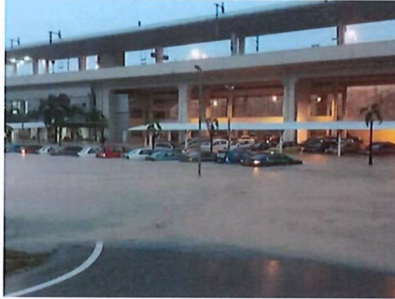
Kawasan persekitaran parkir di KTM Sungai Gadut yang dilanda banjir kilat. -Foto Ihsan bomba
