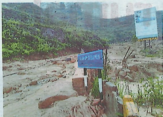
Tanah runtuh di Genting Highlands menyebabkan kakitangan dan penghuni sebuah hotel serta pangsapuri servis terkandas.
