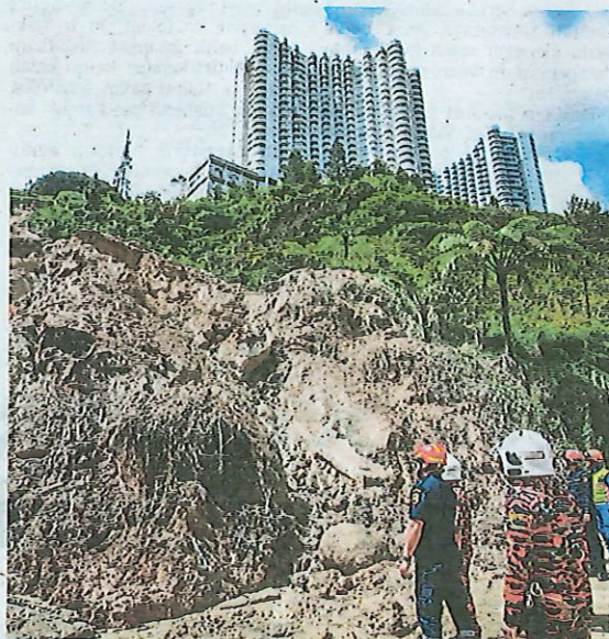
Anggota penyelamat memeriksa struktur tanah runtuh di atas bukit di Jalan Ion Delement, Genting Highlands, kelmarin. (Foto Asyraf Hamzah/BH)
