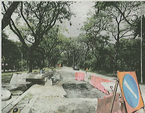
Beberapa bahagian jalan ditutup bagi kerja pelebaran di Jalan Bukit Anak Tukun Templer.
